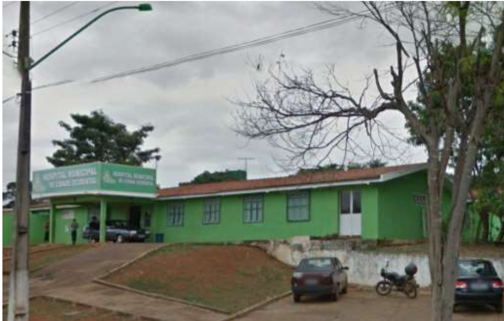
Hospital Municipal de Cidade Ocidental - GO Fonte: Google Maps
